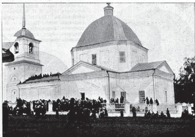
Вид на площадь в день празднования перед церковью, при закладке которой в 1791 году присутствовал сам А. В. Суворов.
